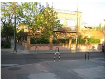
Histórico edificio de San Juan Bautista (esquina calle Bueso Pineda con Agastia)
